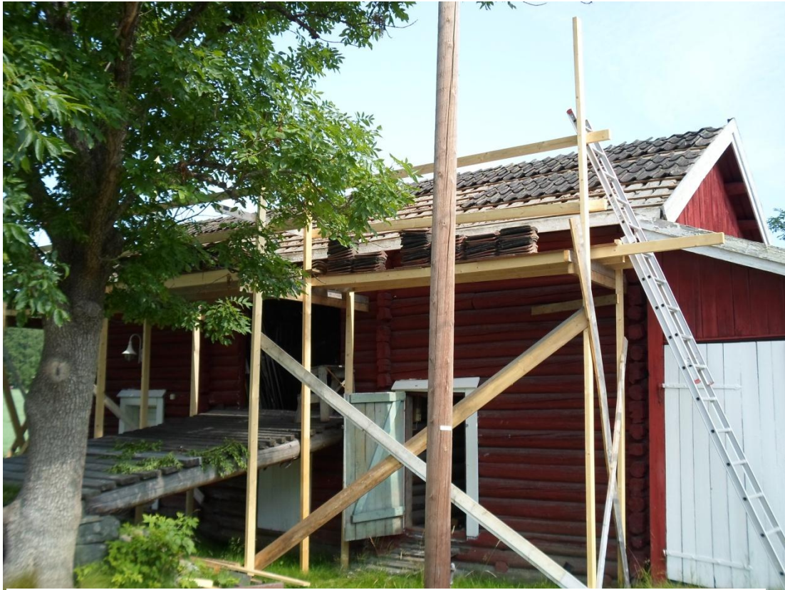
Figure 3: Vi tar av takstein
